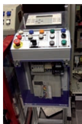
Pupitre communicant sous TCP/IP avec XBT Réf. 2002 PU 002 (pour armoire 2002AR001) ou Pupitre sécurisé pour activité de câblage sur grille Réf. 2002PU003
