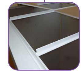
Structure de toit
