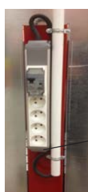
Bloc 4 prises 2P+T avec protection différentielle
