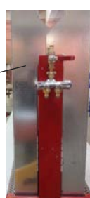
Arrivée d'eau en vanne générale et 2 vannes utilisateurs
